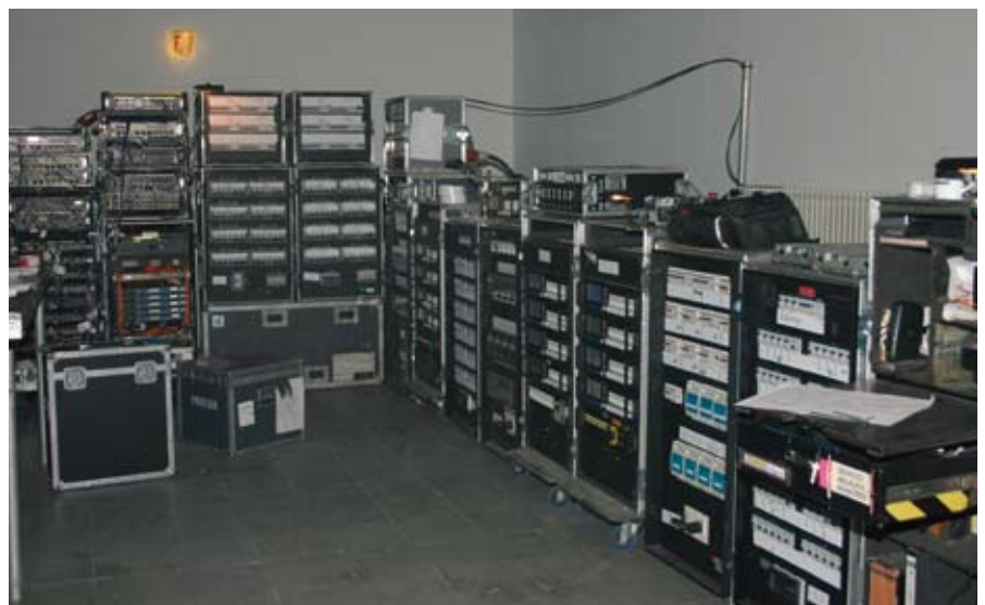
Das Herz der konventionellen Lichttechnik: die Dimmcity im Backstagebereich
